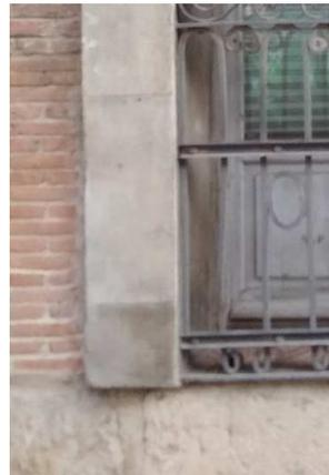
*Mortero del Encercado del hueco y jamba hasta la junta*
