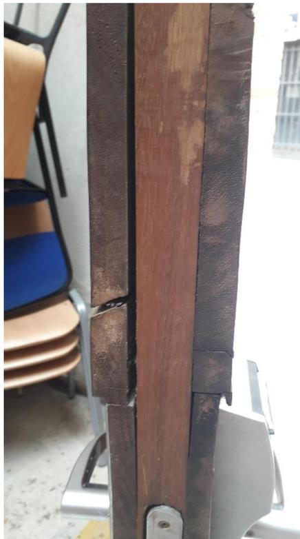
*Detalles de deterioro de la madera en puerta de salida por C/Carmen Calzado*
