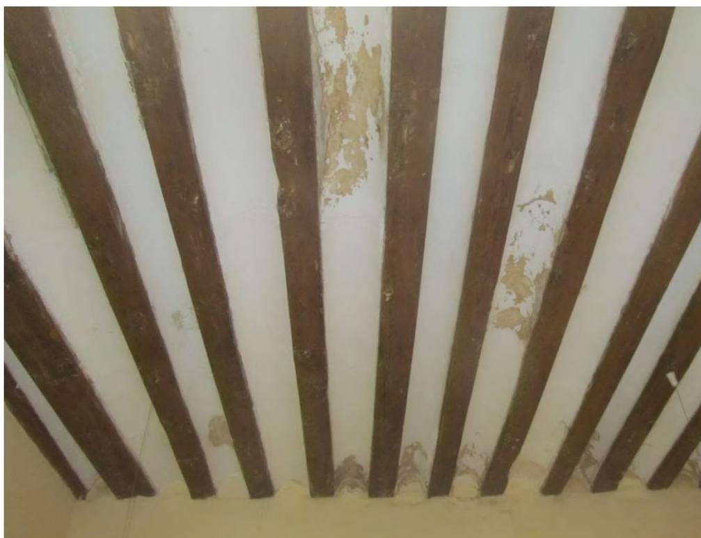
18) Vista del techo de los despachos: vigas de maderas si tratamiento y despegue de pintura de revoltones
